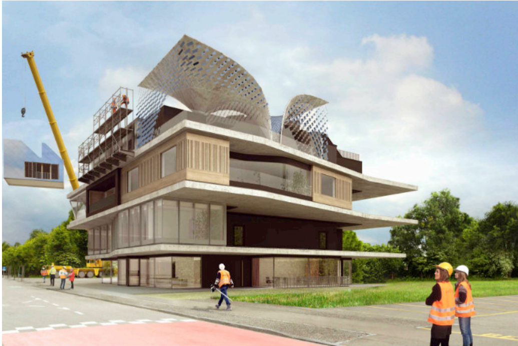
Figuur 5: artist impression van een modulair gebouw waarvan de onderdelen gemakkelijk kunnen worden vervangen en in elkaar passen. [Bron: Empa consortium].
